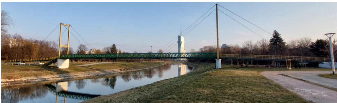
Fig. 1. Cable-stayed footbridge over the Wisłok River in Rzeszów.
